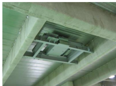
水平TMD設置例
