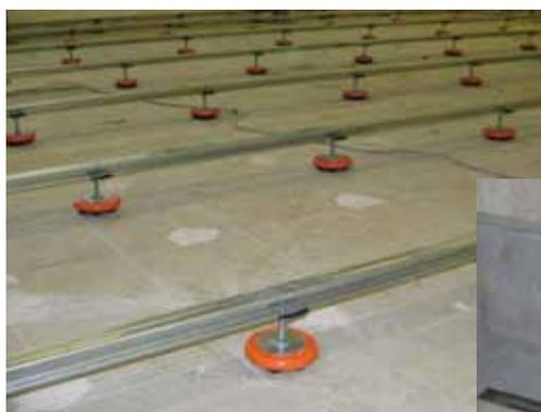
鋼製防振床下地 [乾式浮床下地]
