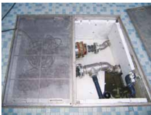
水中ポンプの防振対策 [ミラブロック]
