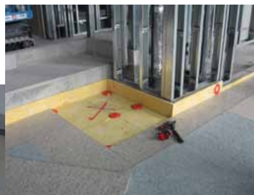
浮床下地 [型枠工法]
