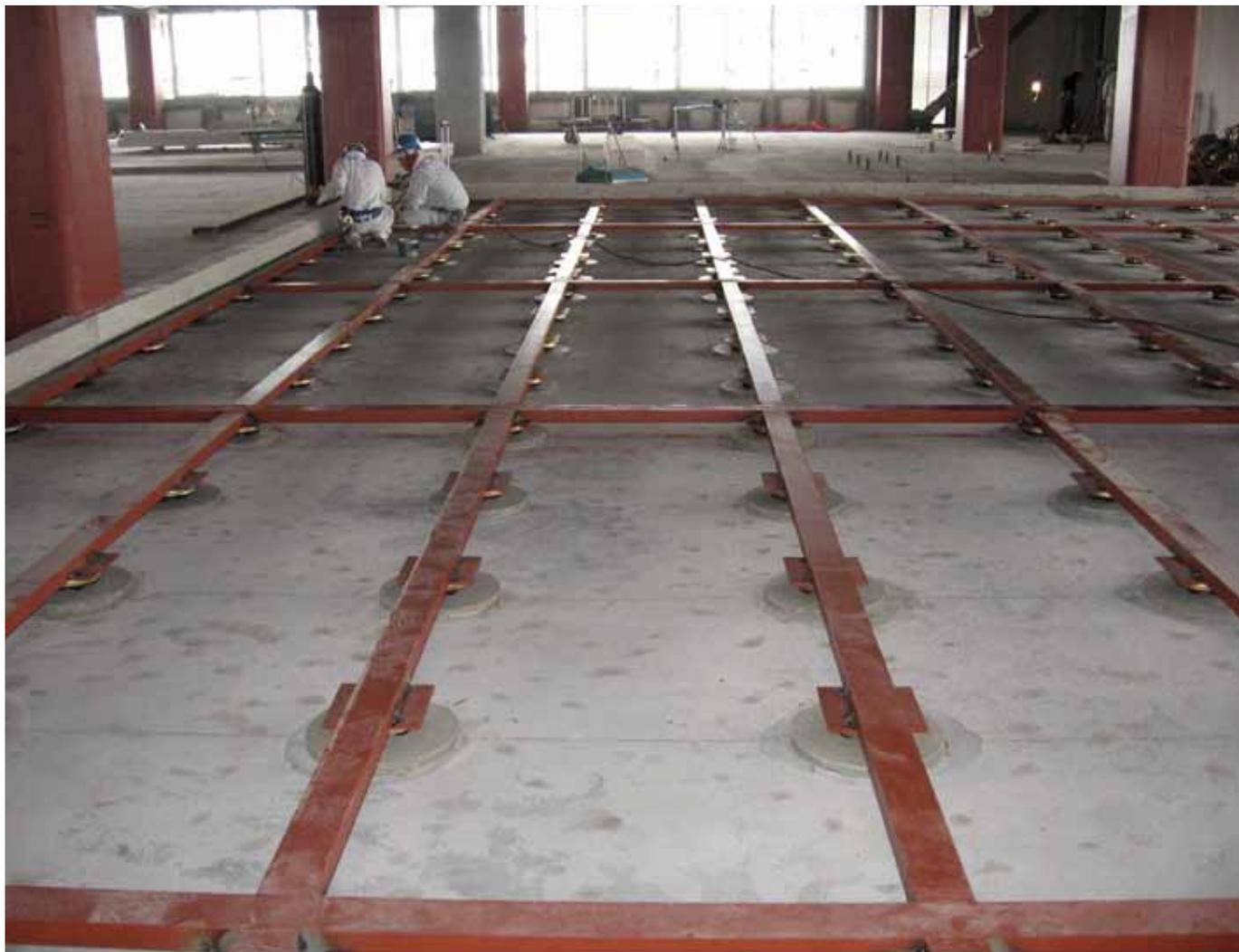
コンクリート浮床下地 [湿式浮床下地]
