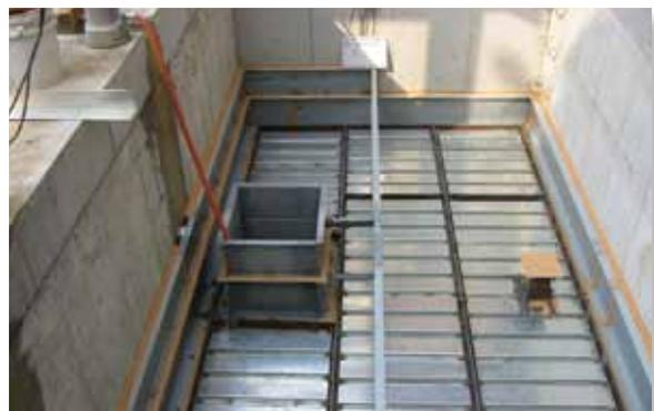
機械式駐車設備リフトビットの防振対策
