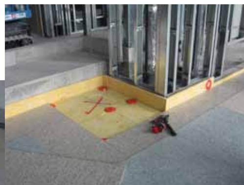
浮床下地 [型枠工法]
