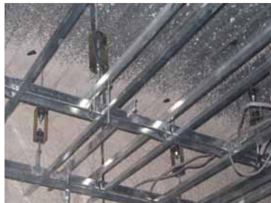
浮き天井下地
