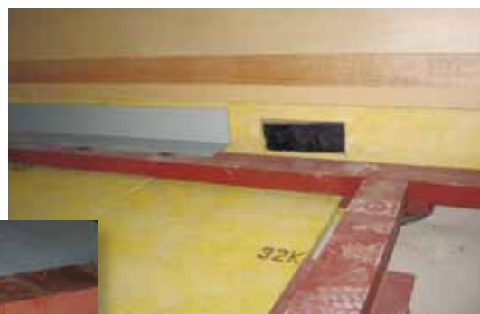
浮床端部[グラスウールとストッパーゴム]
