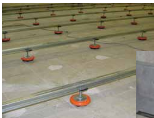
鋼製防振床下地 [乾式浮床下地]
