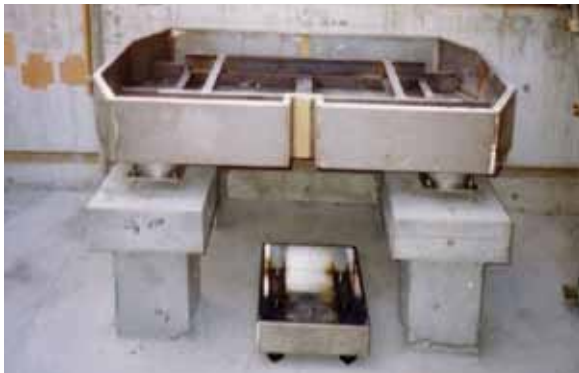
気泡浴槽防振架台
