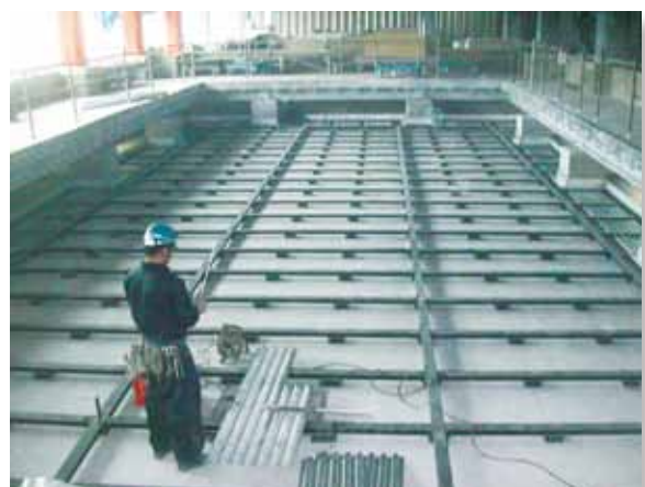
プールの防振対策
