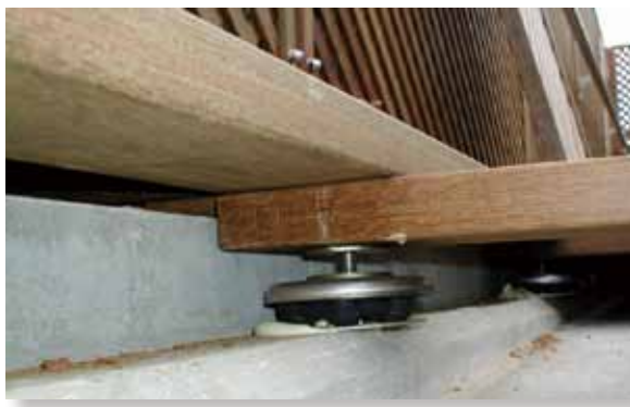
ウッドデッキの防振対策 [ボールダンパー]
