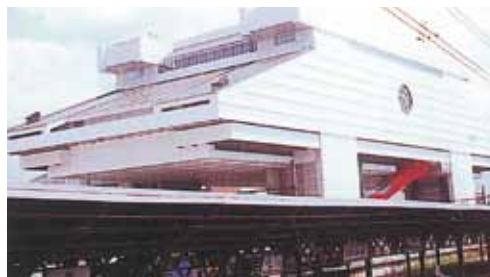
◀ 建築制振装置
