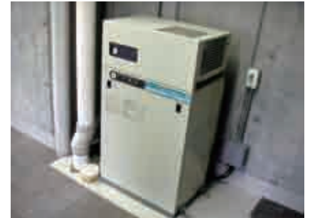
⑥コンプレッサー 圧縮空気を発生する
