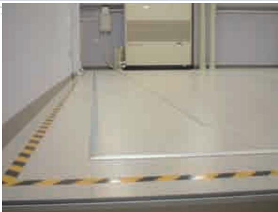
免震床仕上り
