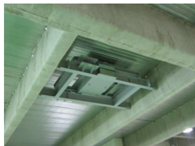
水平TMD設置例
